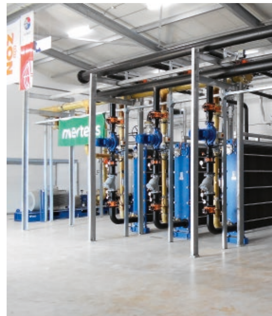
Inrichting pomphuis CLG met warmtewisselaars (links) en
