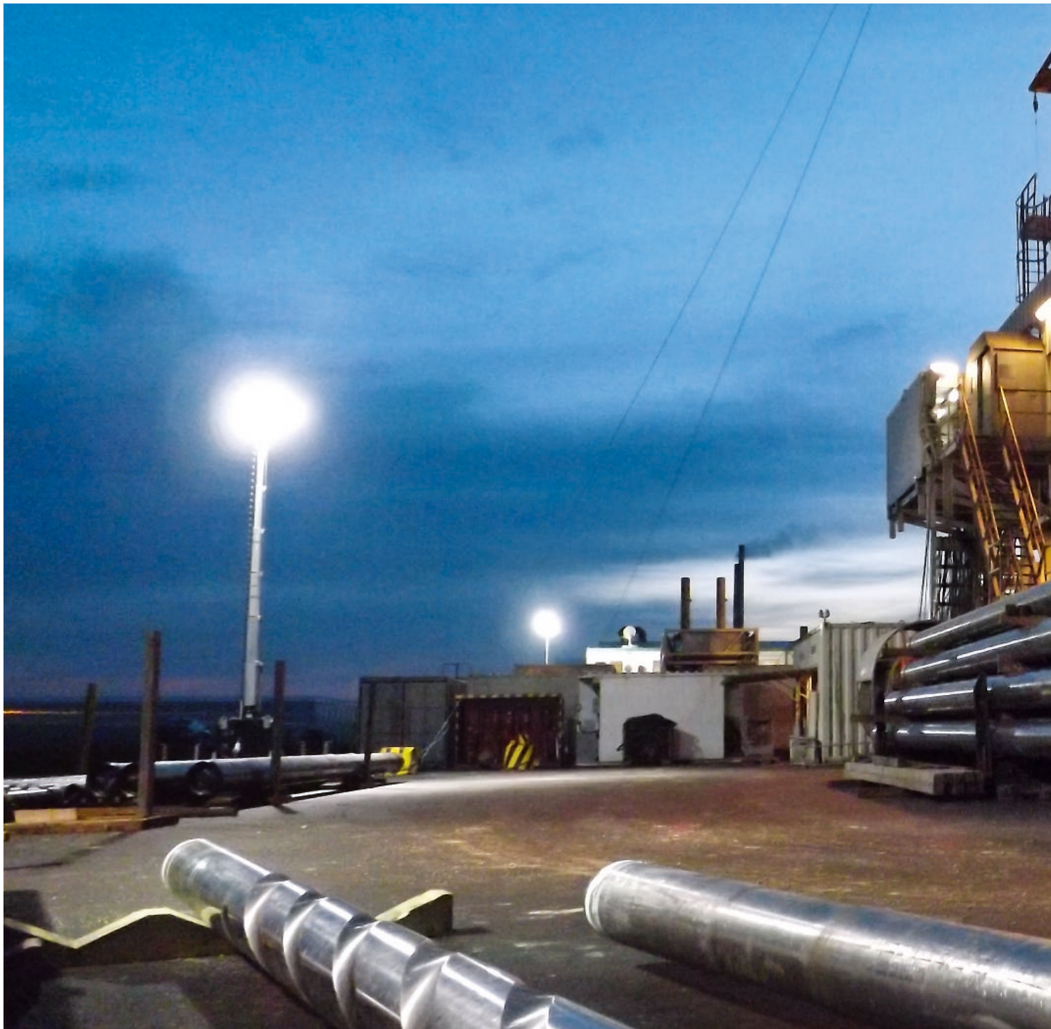
CLG boorlocatie CAL-GT-04 en CAL-GT-05. | Foto beschikbaar gesteld door Radboud Vorage en CLG
